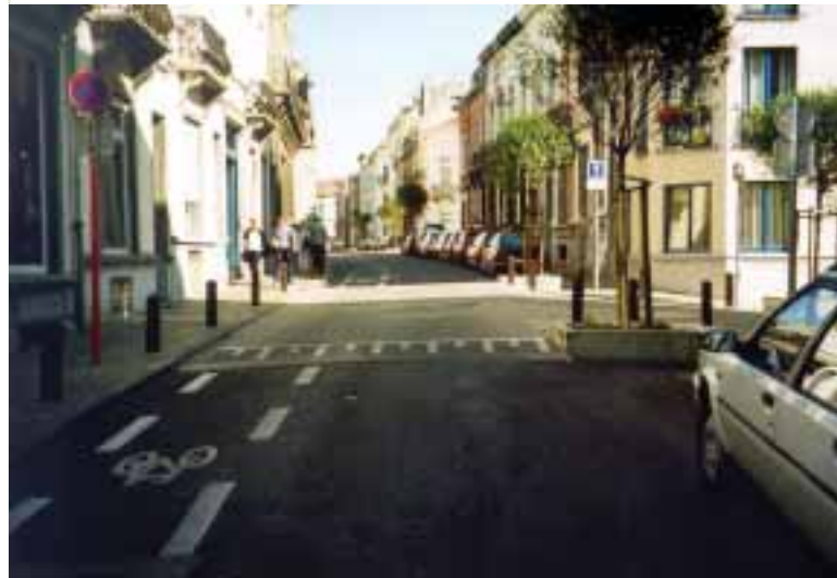
Het verkeersplateau en de visuele en fysieke vernauwing vertragen de rijnsnelheid van het gemotoriseerd verkeer en vestigen de aandacht van de bestuurders op de aanwezigheid van dit T-kruispunt.
