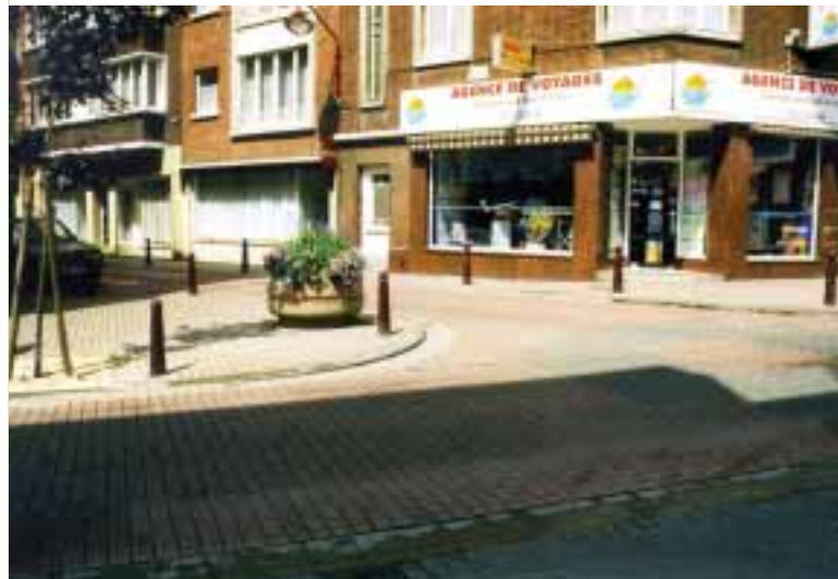
A ce carrefour, des bornes et des bacs à fleurs empêchent le stationnement sur le trottoir. La visibilité entre les automobilistes et les cyclistes circulant à contresens, essentielle en termes de sécurité routière, reste dès lors optimale.
