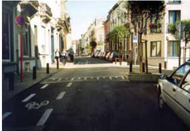
Le plateau ainsi que le rétrécissement visuel et physique ralentissent la vitesse du trafic motorisé et attirent l'attention des conducteurs sur la présence de ce carrefour en T.
